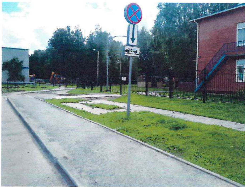
Фото дорожно-уличной сети вблизи МАДОУ «Детский сад №1» г.Тобольска, расположенного по адресу: 7 мкр. дом 52 (корпус 2)
