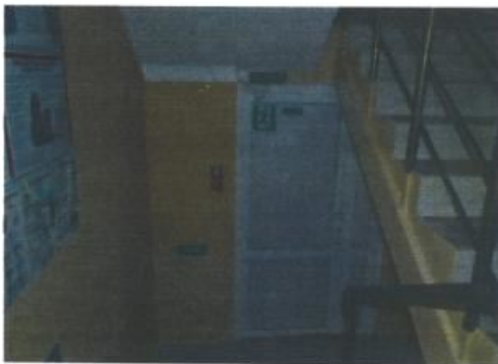
Фото № 13 - Пути эвакуации
