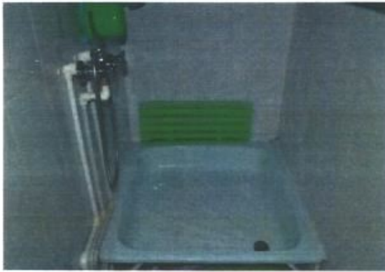
Фото № 9 – Санитарно-гигиенические помещения
