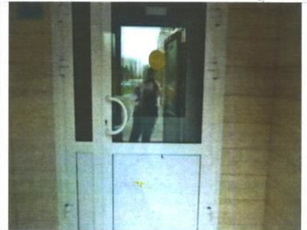
Фото № 14 - Пути эвакуации
