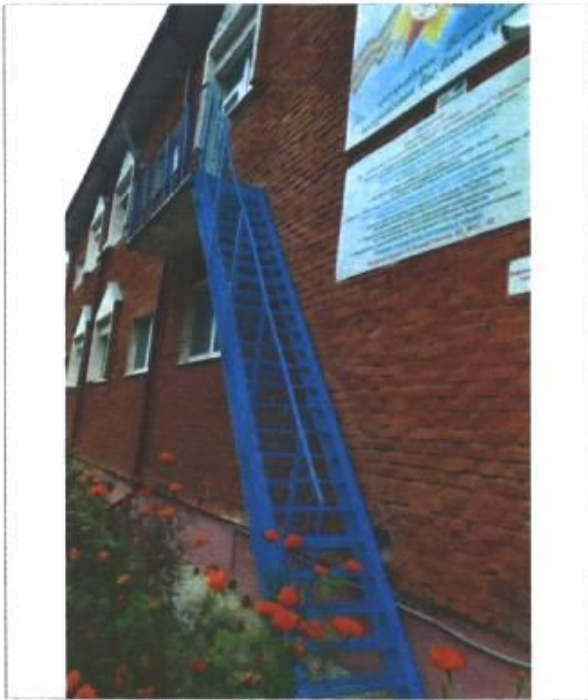
Фото № 15 - Пути эвакуации
