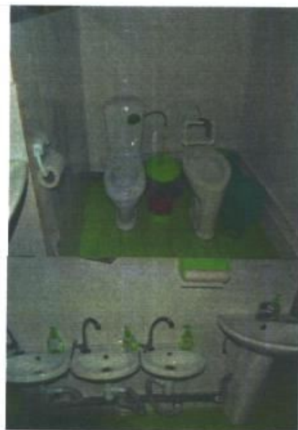
Фото № 8 – Санитарно-гигиенические помещения
